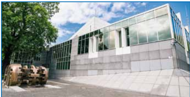
Das GÖRLITZ-Rechenzentrum zieht ins ehemalige Tresorgebäude der Hessischen Landesbank.
